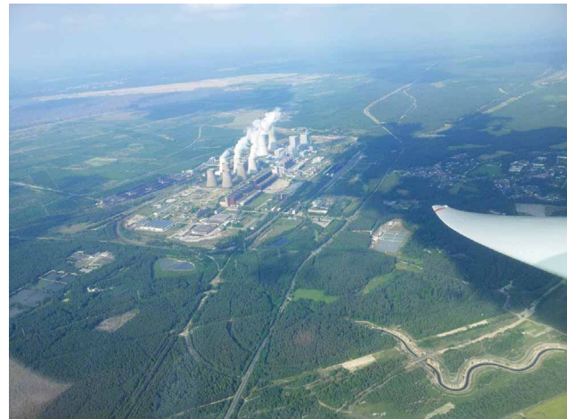
...schön zu erkennen die künstliche Dauerthermik vom Kraftwerk Boxberg
